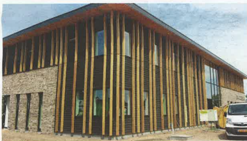
▲ Xyhlo Biofinish toegepast in een zorgcentrum in Putten; 100 procent circulair met een matzwarte uitstraling en minimaal onderhoud. (foto: Regge Hout)
